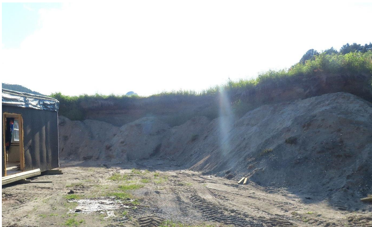
Figur 14. Deler av området foran sandsvalelokaliteten på Stølen ble planert og tatt i bruk som lagerplass.
