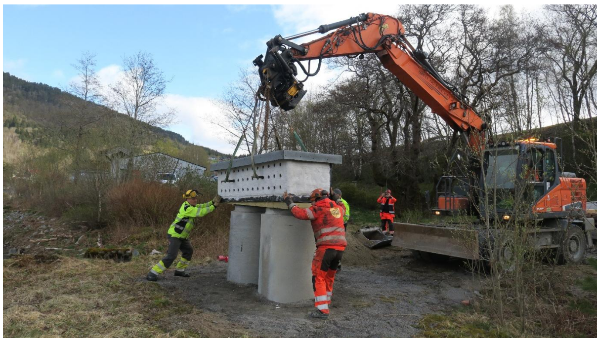
Figur 10. Sandsvalebygget ble løftet på plass ved hjelp av gravemaskin
